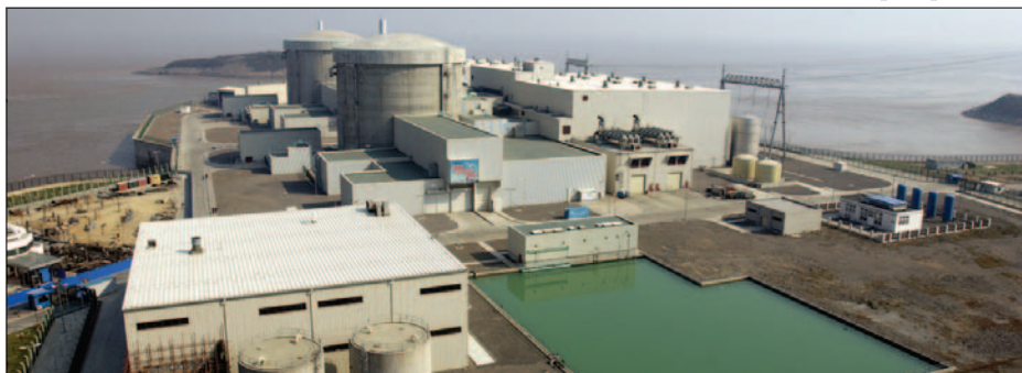
À Qinshan, en Chine, le dernier projet CANDU a été mené à bien avec près de quatre mois d'avance sur le calendrier lorsque le deuxième réacteur a été mis en service en juillet 2003.
