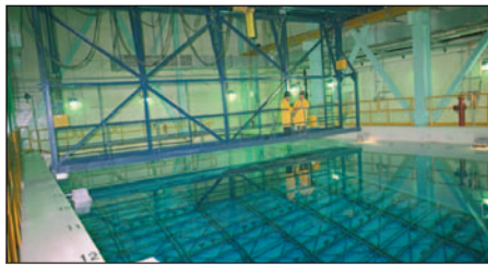
Le combustible nucléaire irradié est entreposé dans des bassins d'eau au sein de chaque centrale nucléaire du pays, où il peut être refroidi et surveillé.
